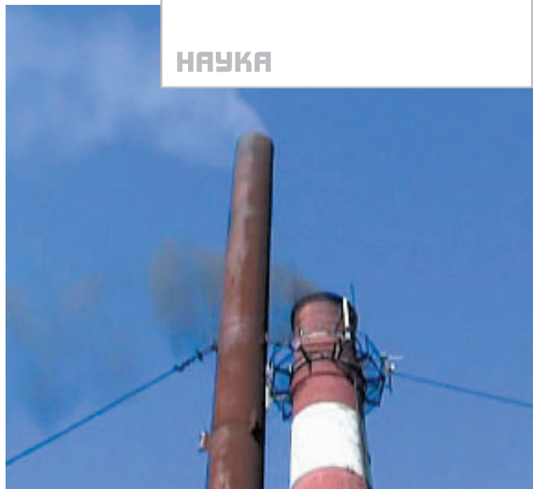
Вид на дымовые трубы. Слева - котельная работает на ВУТ. Справа — котельная работает на угле
