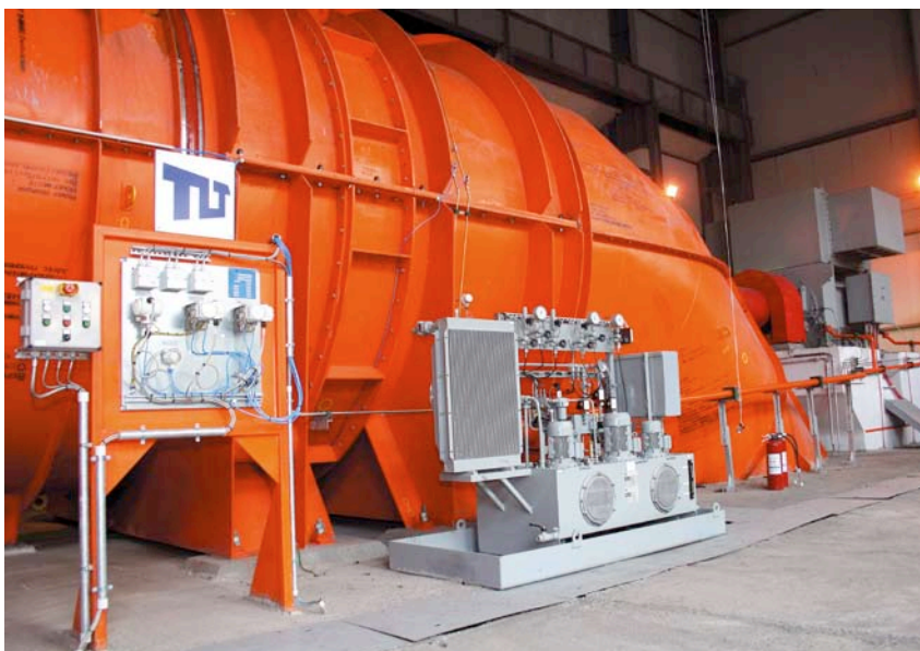
Вентилятор главного проветривания
