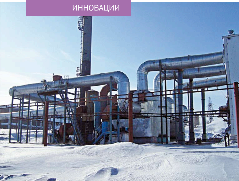
Воздухонагревательная установка ВНУ 04х3 в составе энергокомплекса МТЭУ-ВНУ (04х3) для теплоснабжения вентиляции подземных горных выработок шахты «Тагарышская»
