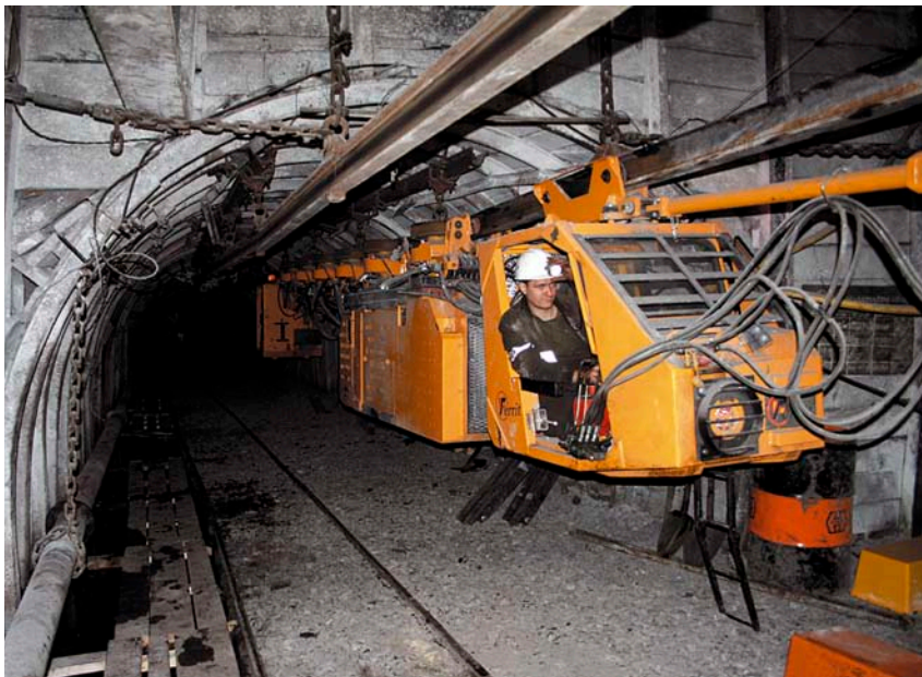
Монорельсовая дорога на шахте «Чертинская-Южная»
