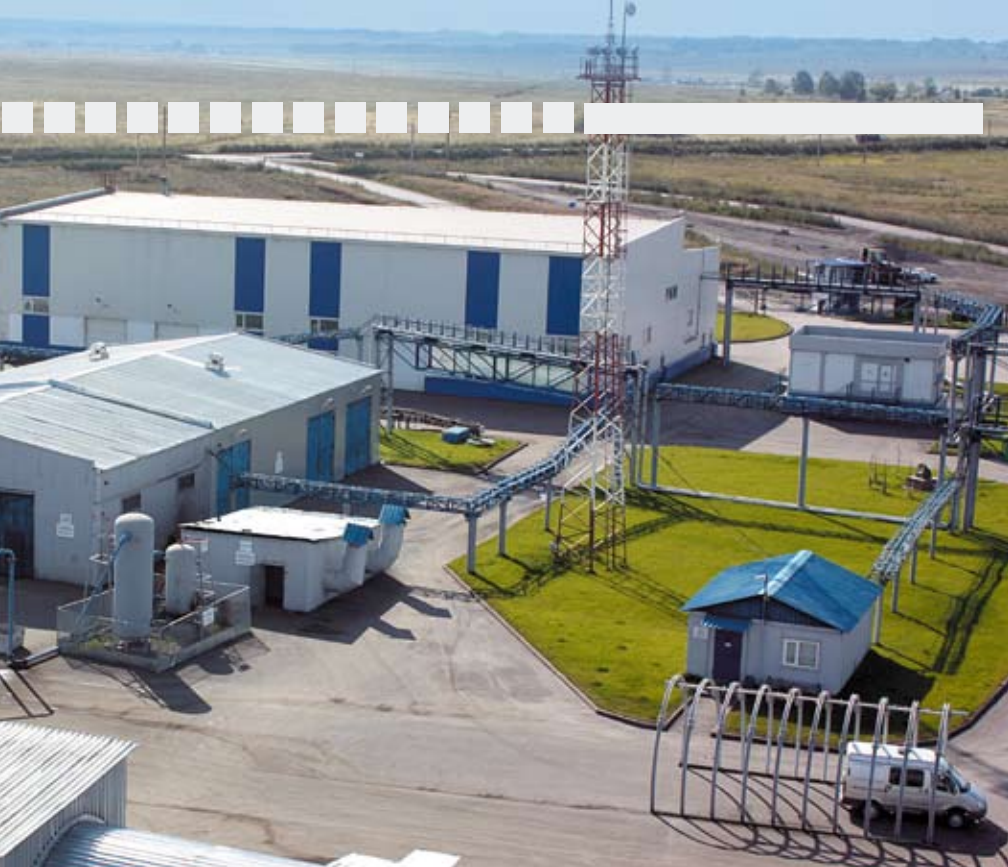
Шахта «Костромовская» построена с учетом всех современных требований экологической безопасности
