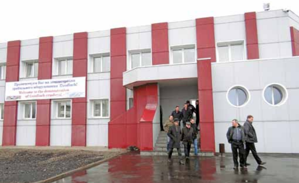
Административный корпус РПБ «КузбассСервис» в г. Мыски
