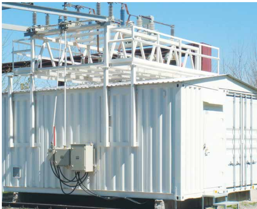
Закрытое распределительное устройство 35 кВ «КЕДР»
