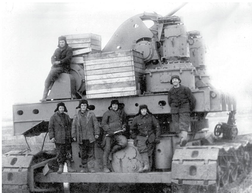
Снимок 1954 года. Из домашнего архива семьи Рудаковых. Монтаж экскаватора СЭ-3 №907 (первый электрический экскаватор («мехлопата») Грамотеинского разреза.
